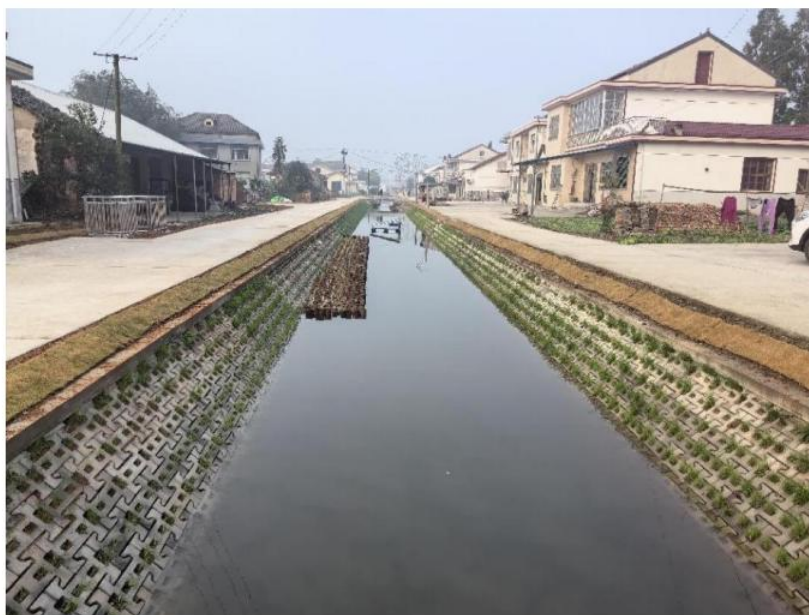
图 2- 13 生态连锁砖护岸示意图
