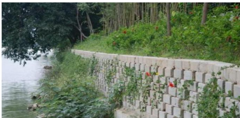
图 2- 12 生态框护岸示意图
