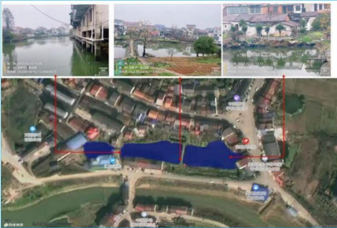
图 4- 23 航运社区廉租房南0.2米黑臭水体情况
