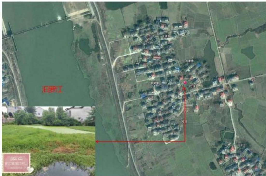
图 4- 58 楼塘现场情况
