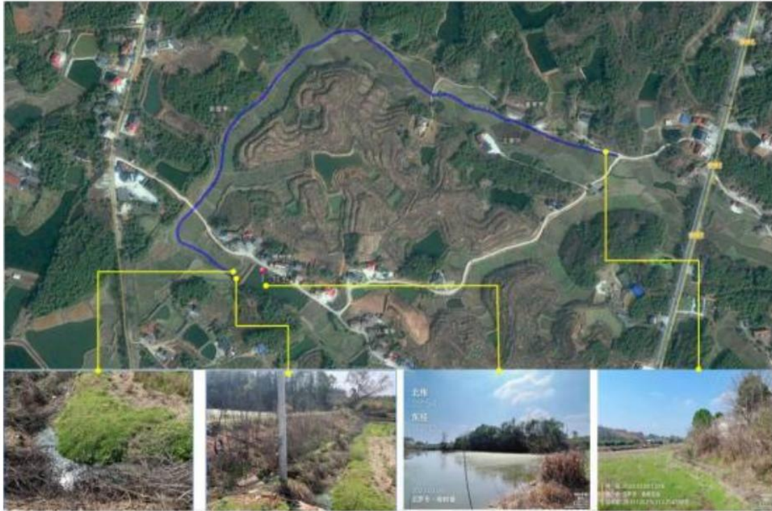
图 4- 27 樟树塘排水沟黑臭水体情况
