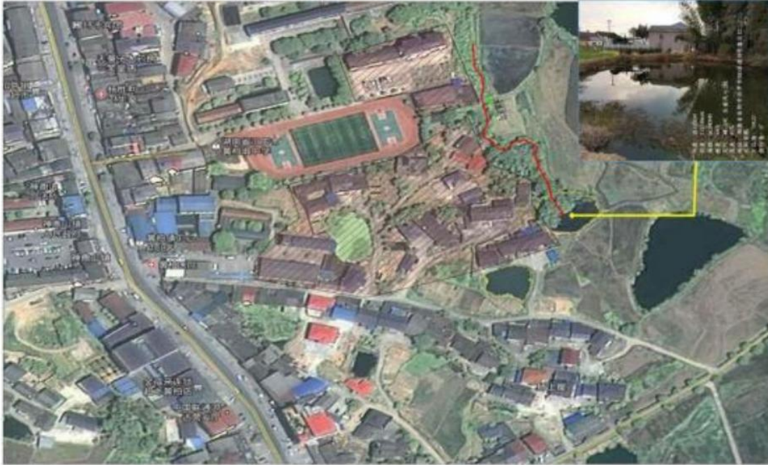
图 4- 16 黄柏中学食堂排水口黑臭水体情况
