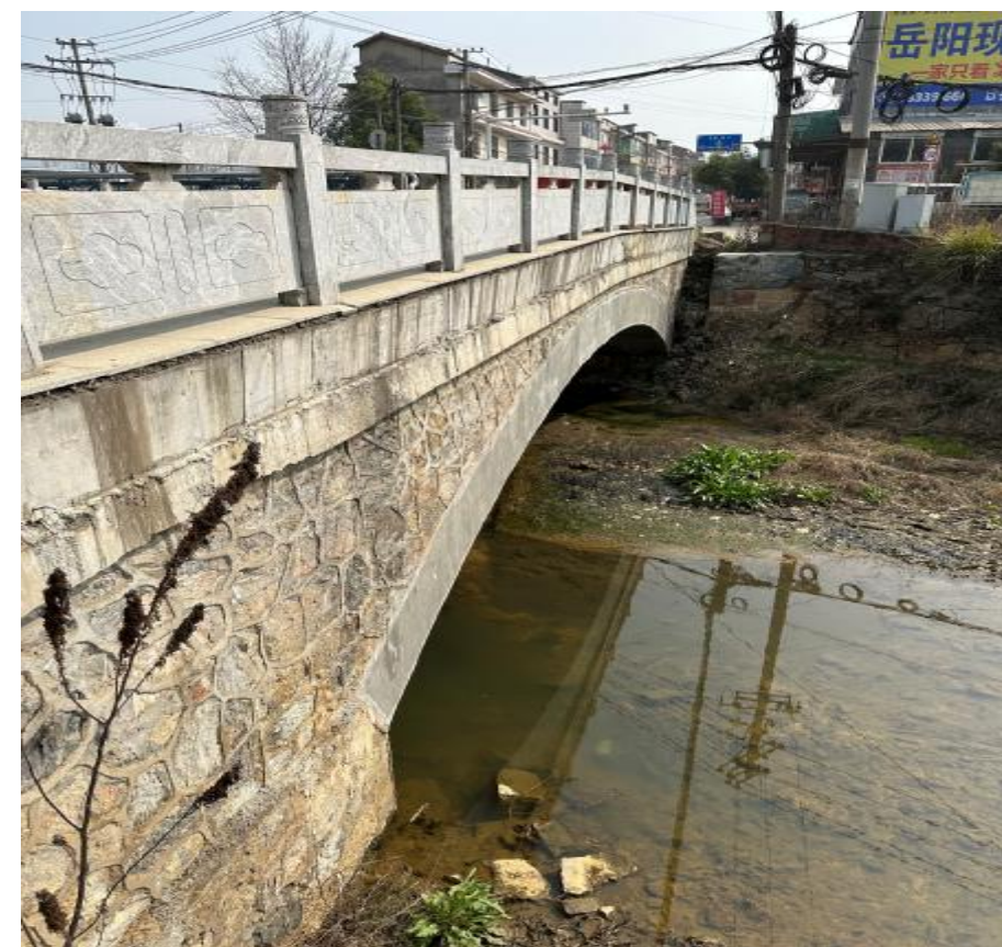
图 1 现状文桥沟 K4+280 樟树港桥照片
