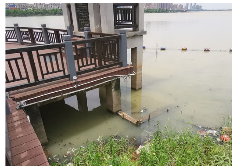
图 3.9 东湖排水箱涵分流井及东湖排放口现状
