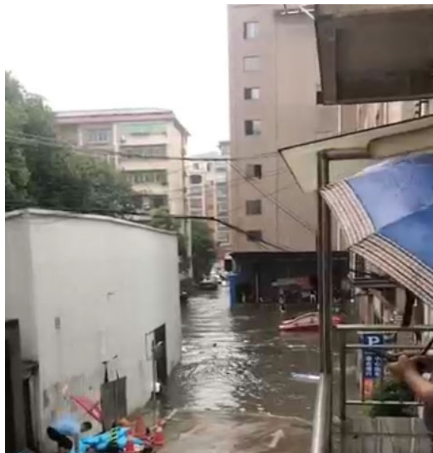
图 3.8 2021 年 6 月东泰花园内涝情况现场照片
