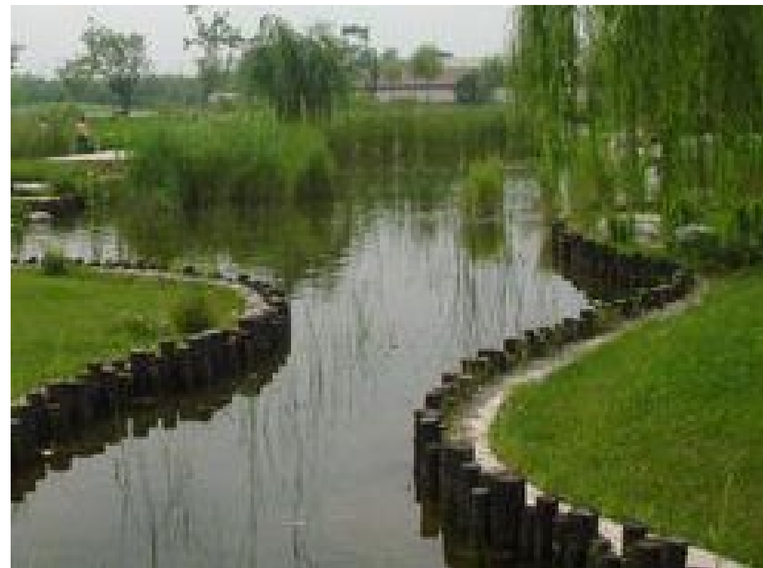
图 5.9 木桩驳岸示意图
