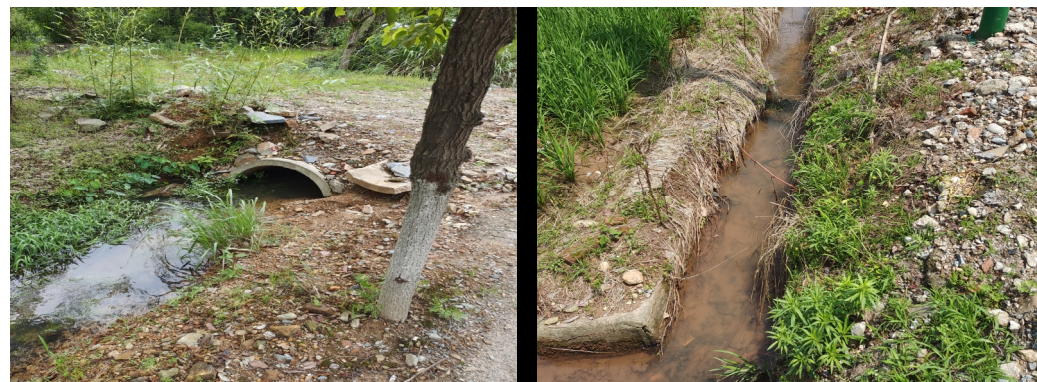
现状管涵及排水沟
