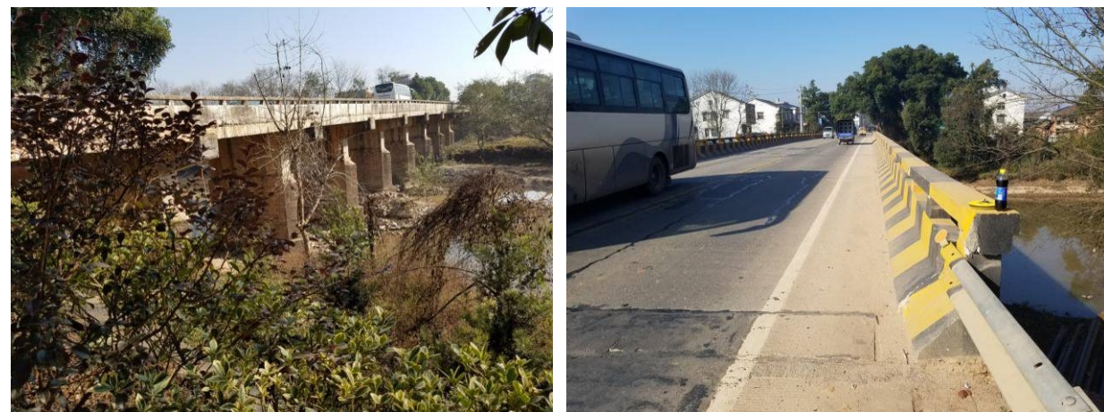
图 6-2 李家背桥现状照片
