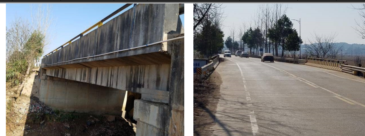
图 6-1 大桥村中桥现状照片
