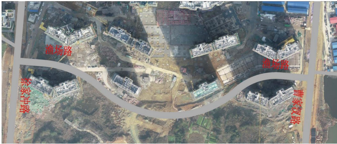
现状区域航拍图麦子港片区道路
