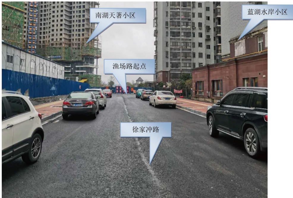
涂家冲路现状一部分路段已修建
